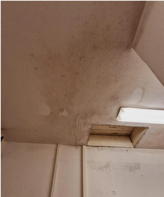
Abbildung 3.6: Schimmelbildung an der Decke im Flur
